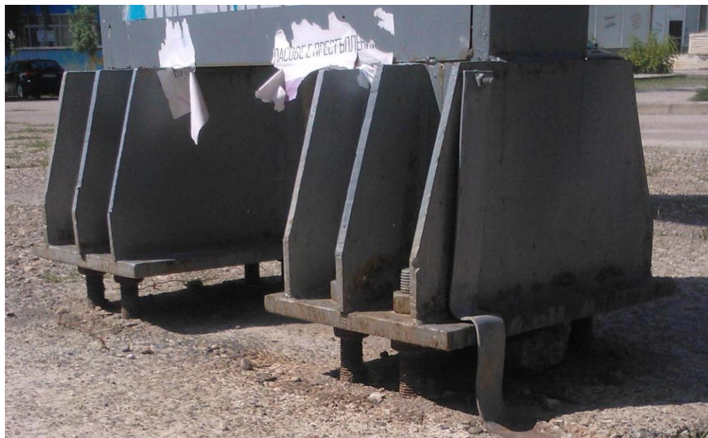
Фиг. 10. Анкерни болтове с гайки под базовата плоча. Реализация
