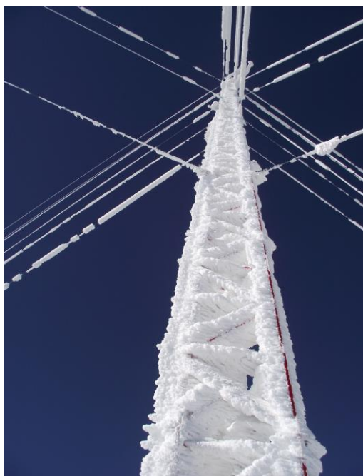
Фиг. 1. Метеорологична мачта при интензивно обледяване от скреж
