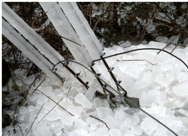
Фиг. 4. Стъкловиден лед върху анкерна група въжета с обрушени парчета лед от високите нива
